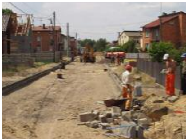
Prace na ul. Miodowej w Koźminku fot. M. Kaczmarek
